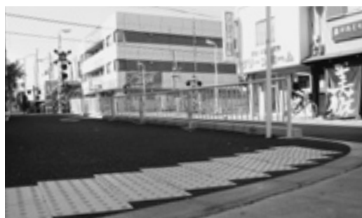
段差解消を施した歩道
