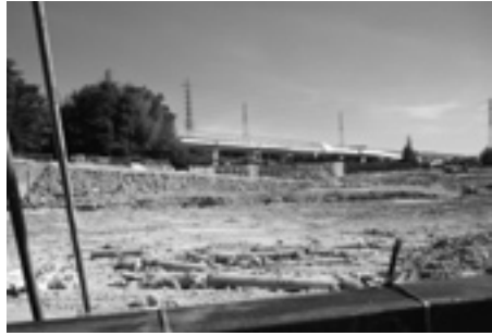
解体作業中の警察学校跡地
