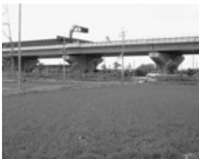
大規模商業施設誘致が検討される星田北地域
