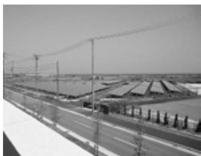
太陽光発電施設(淡路市)
