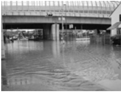
8月14日の豪雨により冠水した私部西線
