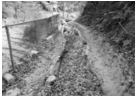
大雨により被害のあった石仏の道
