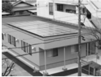
屋上にソーラーパネルを設置した第2別館
