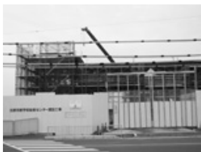
建設中の新学校給食センター
