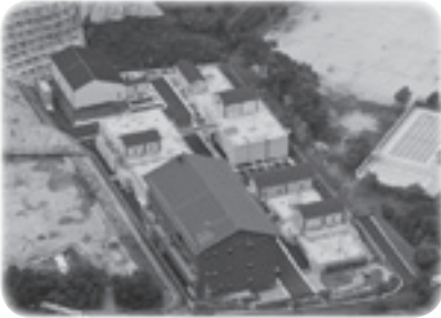
星の里浄水場
