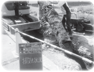
配水管布設替工事
