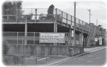
星の里いわふね駐車場
