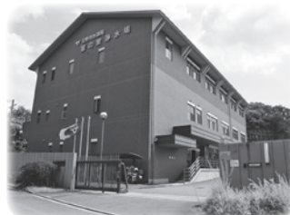
星の里浄水場
