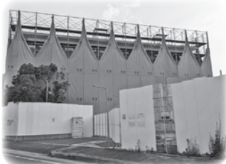
解体が進む第一中学校
