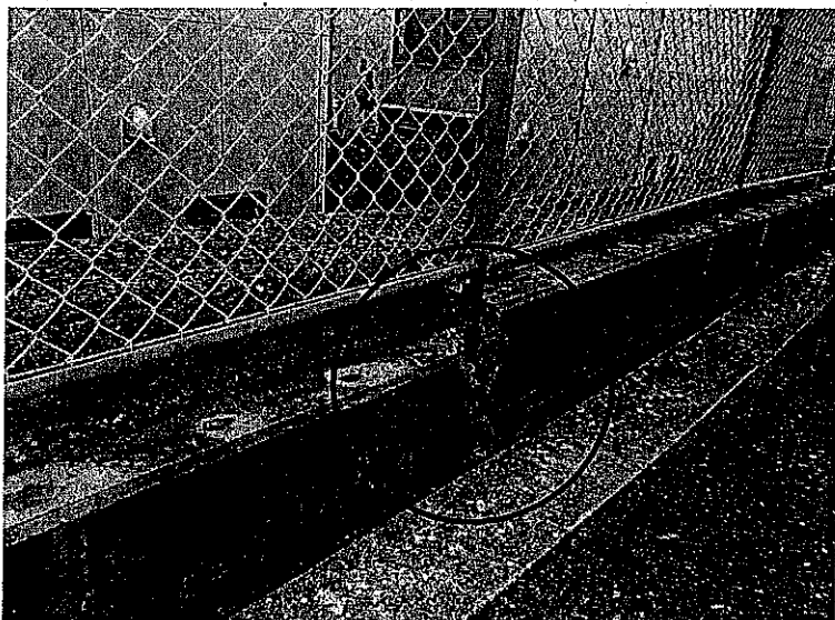
No.2 妙見坂6丁目地内道路（側溝）
