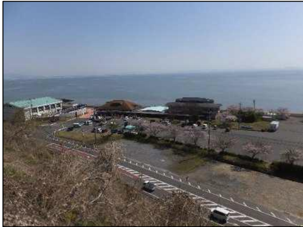
①道の駅鹿島全景
